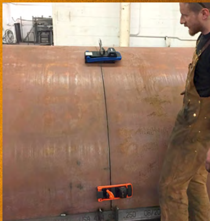
СТРОИТЕЛЬСТВО РЕЗЕРВУАРОВ — БРЕСЛАУ / ПОЛЬША
