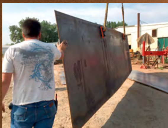
СТРОИТЕЛЬСТВО ЗДАНИЙ ПАВИЛЬОННОГО ТИПА – БЛУМФИЛД / США
